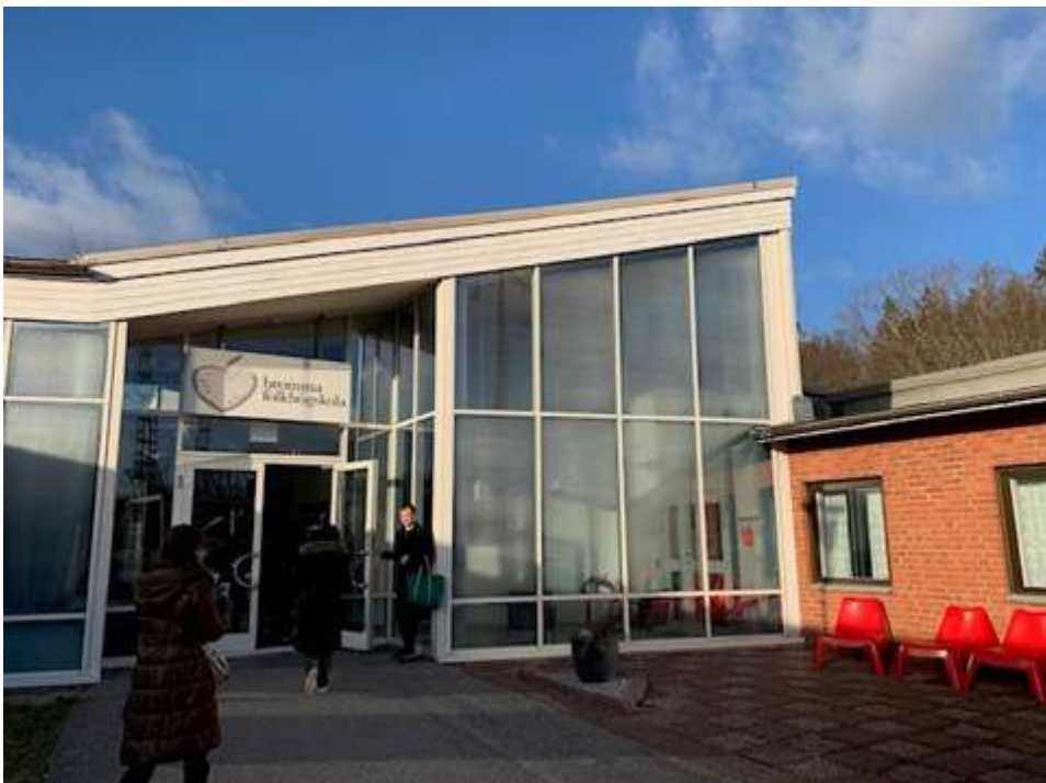
図1：ブロンマ高校の外観
