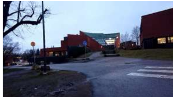
図1. Undergraduate Centre の建物。 中には理学部の講義室や食堂などがある。
